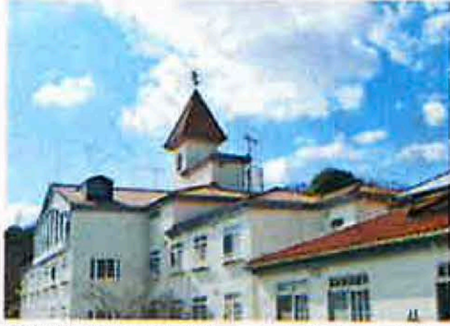
【外観】周辺は自然に囲まれ静かな環境
